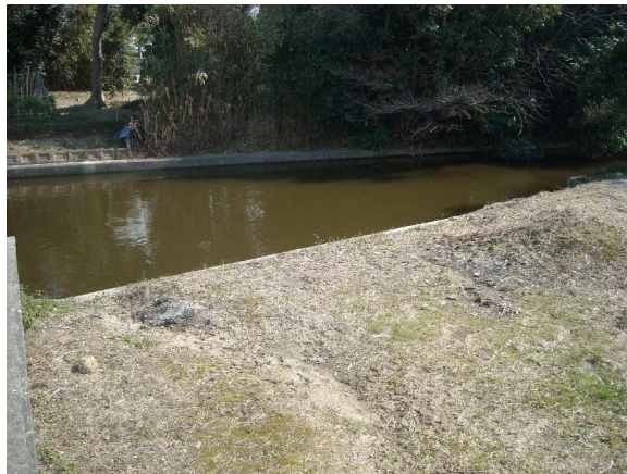
敷地裏側水路の写真
